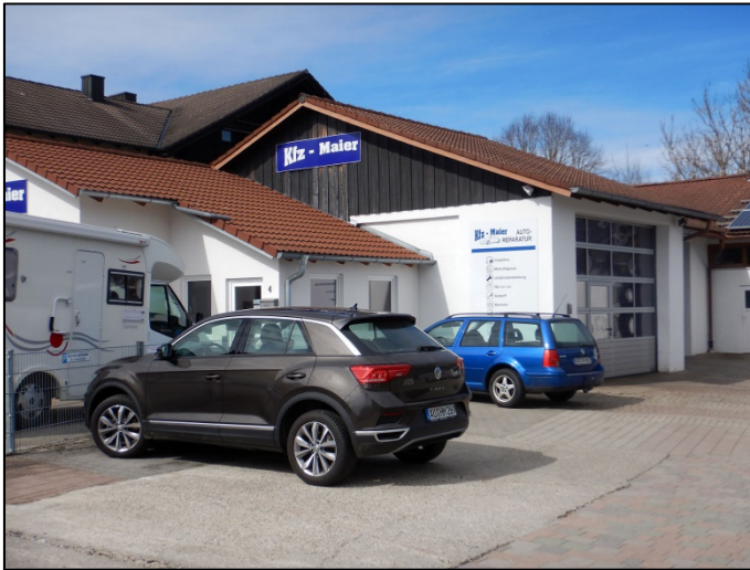
Abbildung 25: Blick auf die Ostfassade des Betriebsgebäudes
