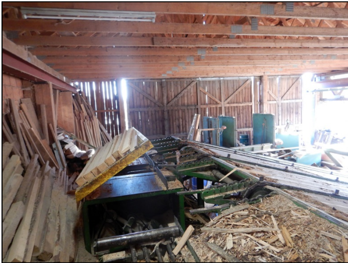
Abbildung 27: Blick auf die Südfassade der Sägehalle
