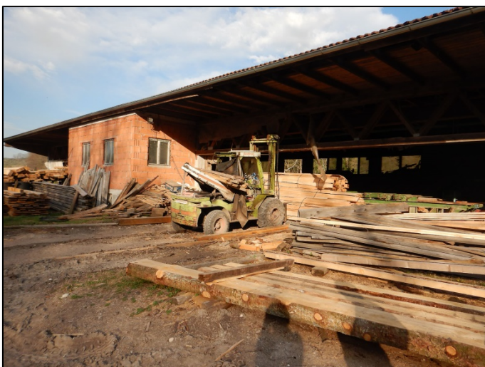
Abbildung 29: Westfassade Sägewerk (Ausgabe Kantholz)
