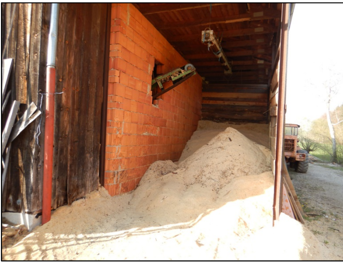
Abbildung 32: Anbau an der Ostfassade (Lager für Sägemehl)
