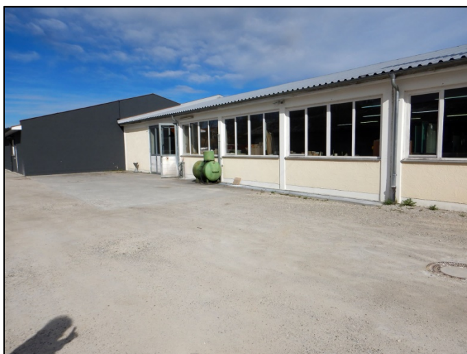
Abbildung 10: Lieferzone im Westen des Betriebsgebäudes
