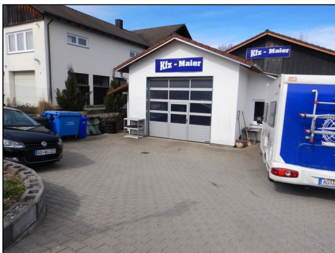
Abbildung 24: Blick auf die Südfassade des Betriebsgebäudes
