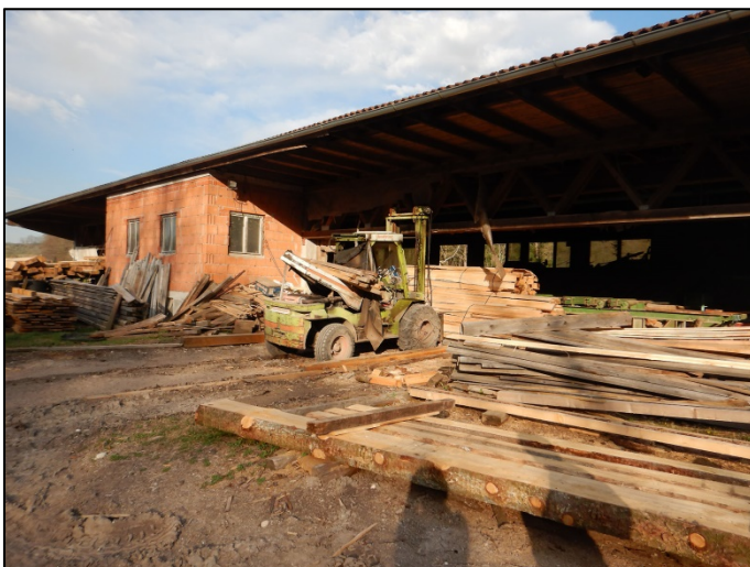
Abbildung 6: Westfassade Sägewerk (Ausgabe Kantholz)
