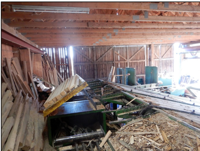
Abbildung 13: Blick auf die Südfassade der Sägehalle
