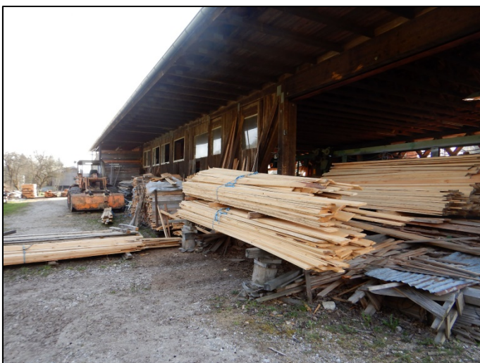
Abbildung 7: Blick auf die Ostfassade des Sägewerks
