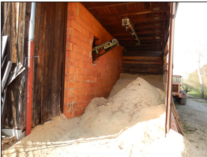
Abbildung 15: Anbau an der Ostfassade (Lager für Sägemehl)
