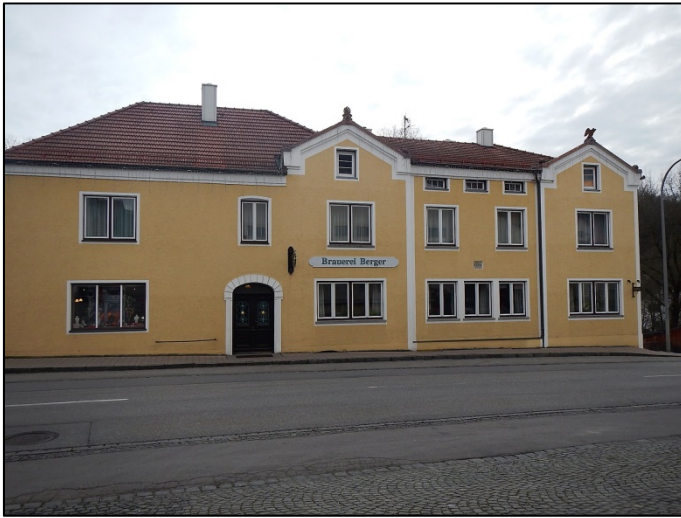
Abbildung 16: Wohnhaus "Öttinger Straße 3" (hier: IO 8)
