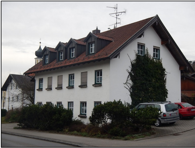
Abbildung 10: Wohnhaus "Öttinger Straße 9" (hier: IO 1)
