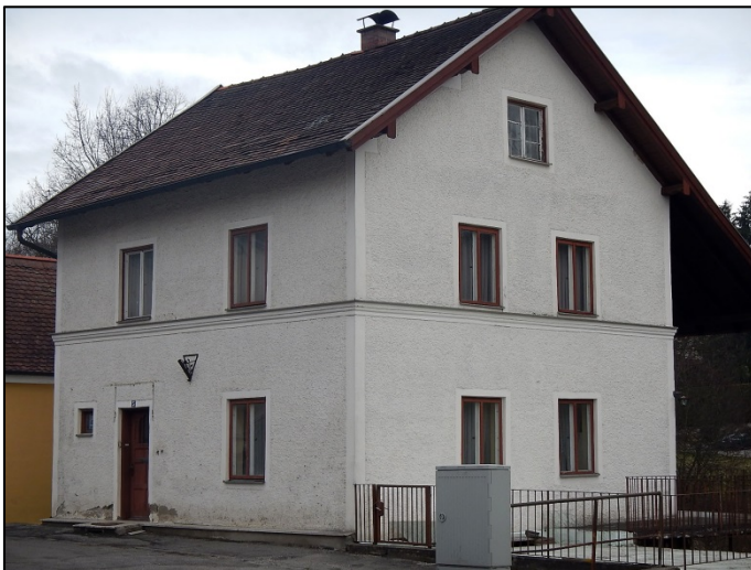
Abbildung 17: Wohnhaus "Öttinger Straße 5" (hier: IO 9)
