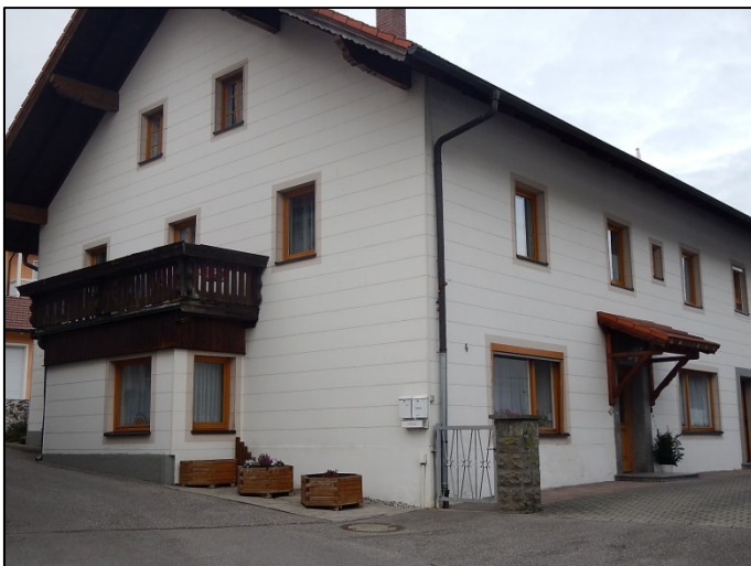
Abbildung 15: Wohnhaus "Öttinger Straße 4" (hier: IO 7)
